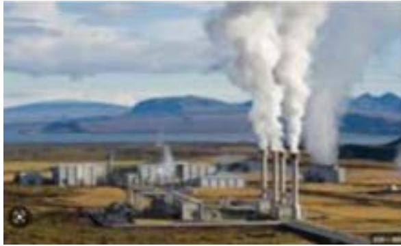
Сурет 2 – Геотермалдық электр станциясы
